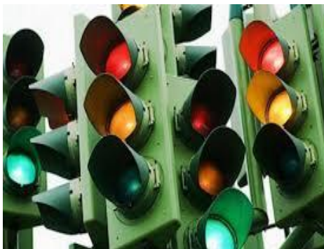
Блоки управления светофорами
