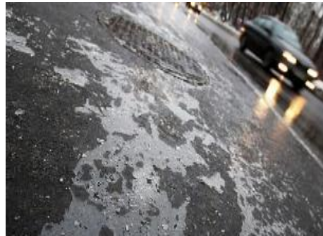
Датчики состояния дорожного полотна
