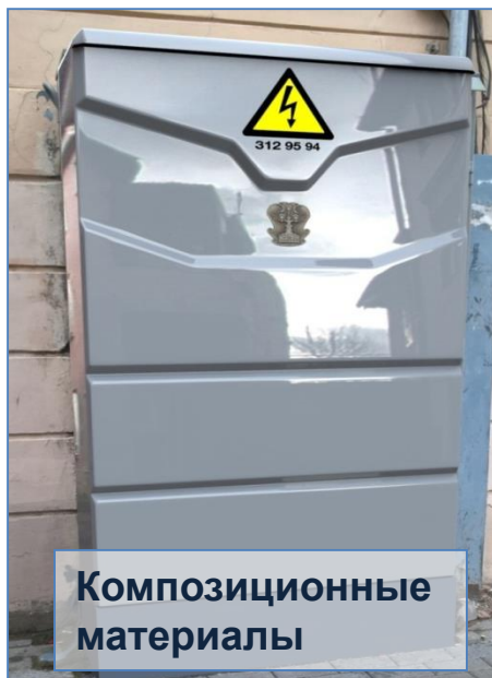
Защитные вводные щитки для подключения кабеля в опорах освещения
